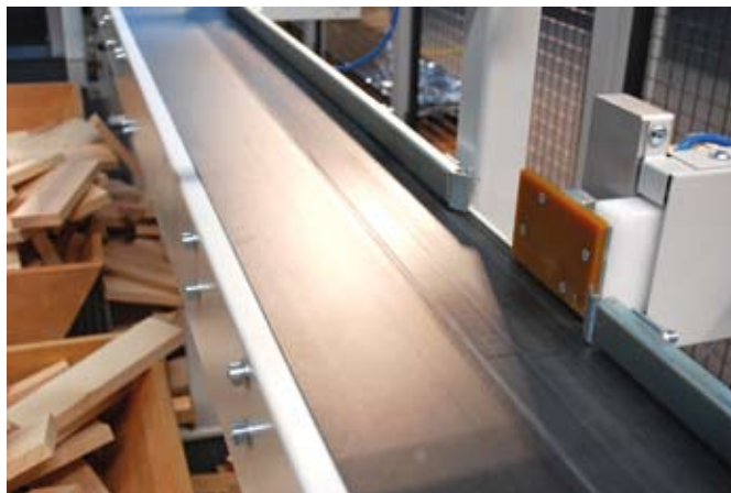
A beérkező szárított fűrészáru hibakiejtése a nagy teljesítményű darabolófűrészekkel
